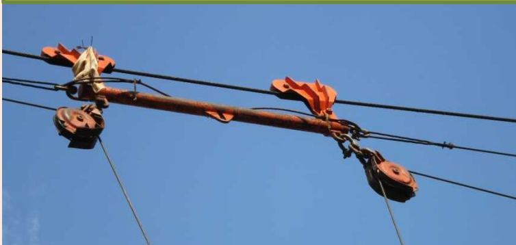
パイプキャリア下のリフティングライン用 ガイドブロックに
